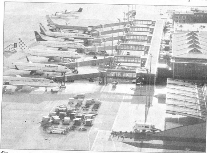
Über sechs Fluggastbrücken gelangen die Passagiere vom Terminal B aus in die Flugzeuge. Mit höchsten Sicherheitsstandards können sie das beruhigt tun.
